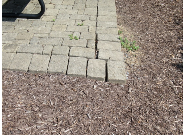
Paver displacement
